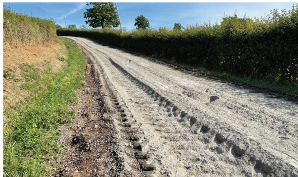
Pendant les travaux de consolidation de la voirie à Saint-Julien-de-Civry, entre les Villards et Charnay
